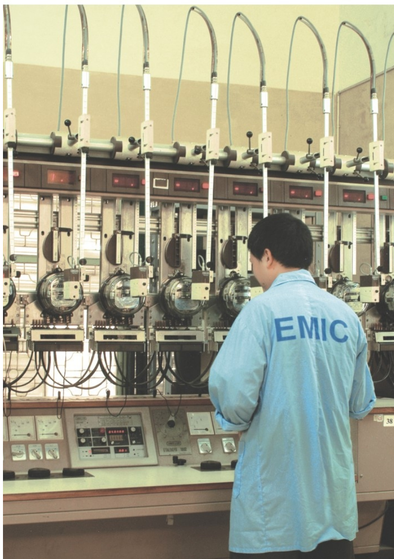
Hiệu chỉnh Công tơ điện 1 pha Calibrating Single phase electric meters
